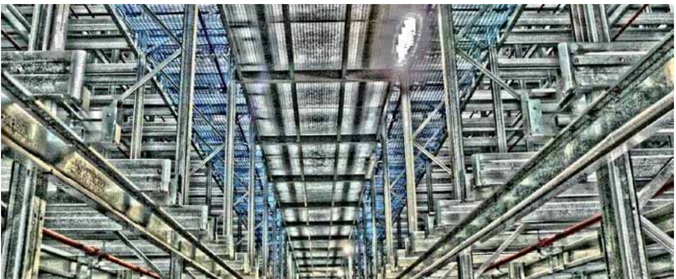
Abb. A2.1 Wartungssteg mit Hochregallagersicherungsnetzen
