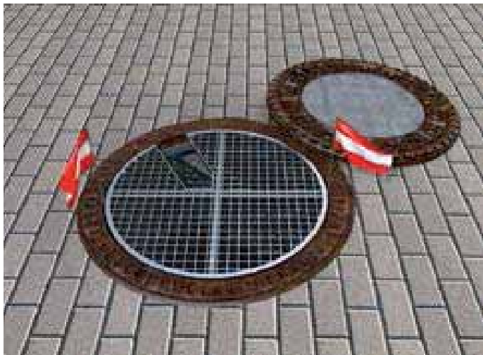
Abb. 8 durch Abdeckkroste gesicherte Schachtöffnung
