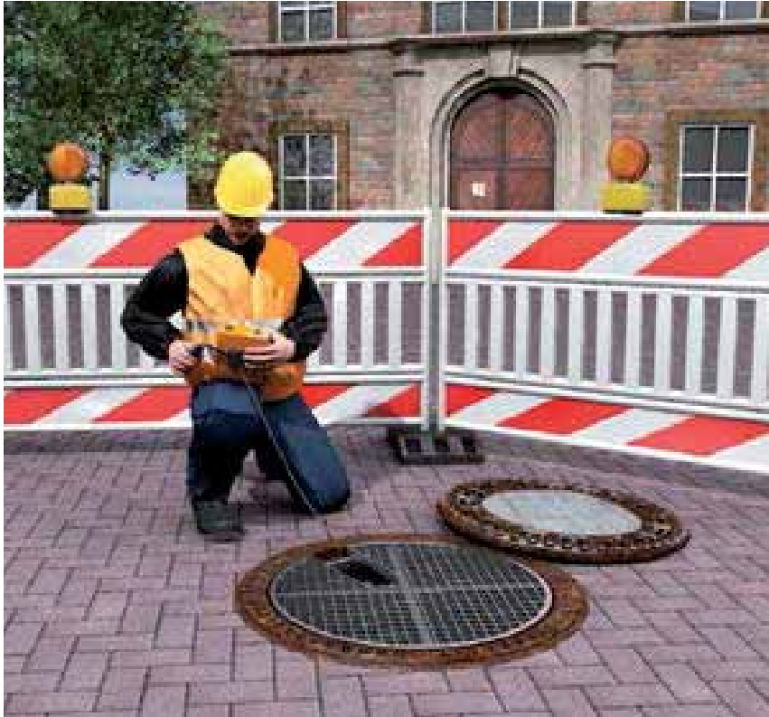
Abb. 9 Überprüfen der Schachtatmosphäre
