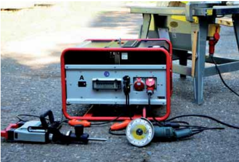
Abb. 24 Drei Betriebsmittel – Baustellenkreissäge direkt angeschlossen, Abbruchhammer und Winkelschleifer mit jeweils einer zwischengeschalteten PRCD
