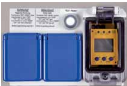
Abb. 11 IMD mit Prüftaste und zugeordneten Steckdosen
