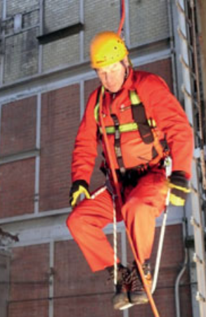
Abb. 3 Halteseil mit Längeneinstellvorrichtung
