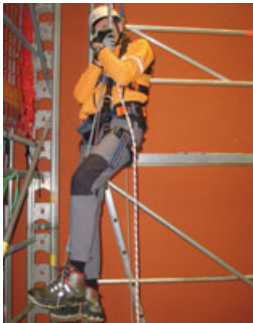
Abb. 5 Anwendung der Prusikschlinge
