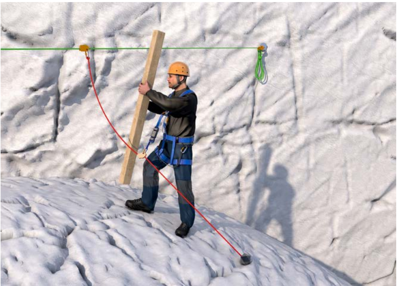
Abb. 5 Verwendung von PSAgA/Absturzschutzsystem
