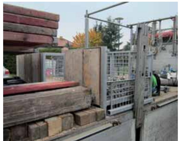
Bild 150: Barenen als Formschluss für liegendes Gerüstmaterial
