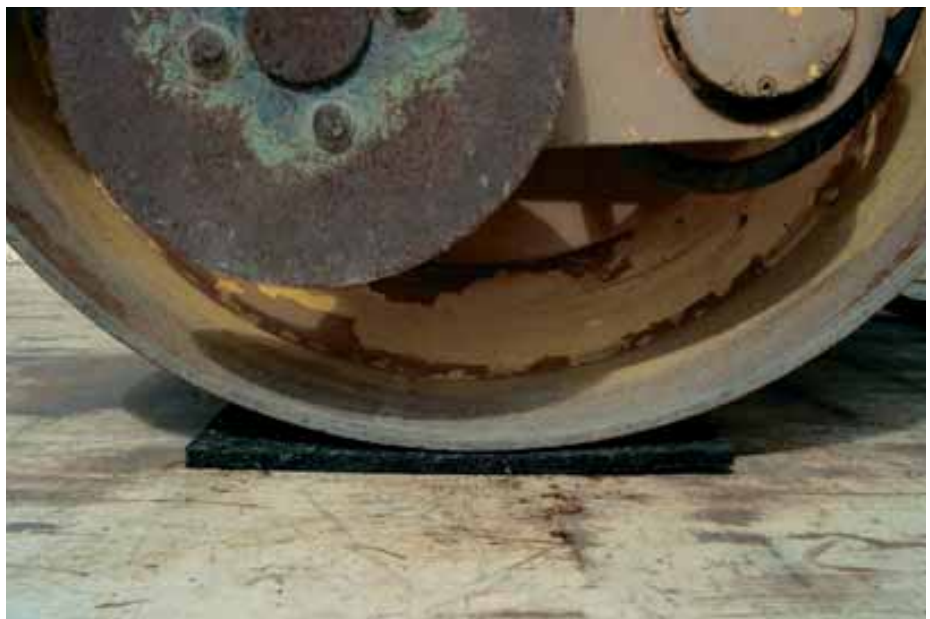
Bild 9: Einsatz einer Anti-Rutschmatte unter einer Walze
