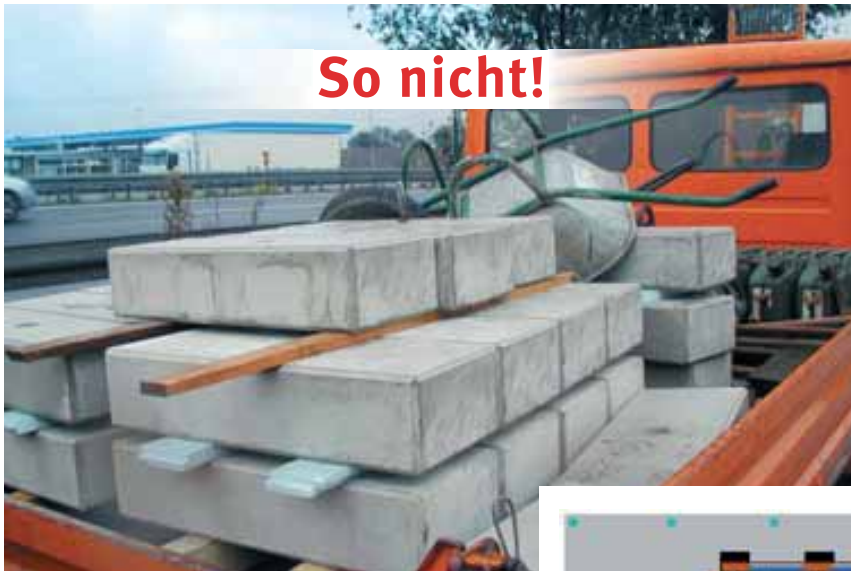
Bild 44: Transport von Betonfertigteilen
