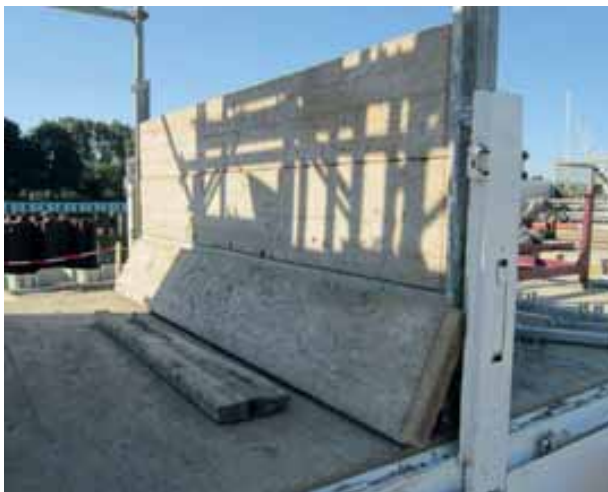
Bild 149: Stirnwand aus Gerüstbohlen
