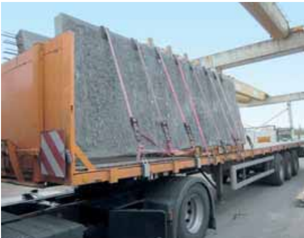
Bild 155 und 156: Transport von Betonfertigteilen auf A-Böcken
