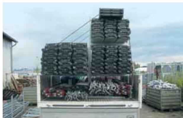
Bilder 141 und 142: Transport von Gerüstmaterial in Barenen
