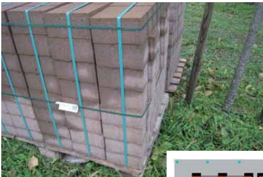
Bild 46: Eine Verpackung mittels Umreifungsbändern ersetzt nicht die Bildung einer Ladeeinheit.
