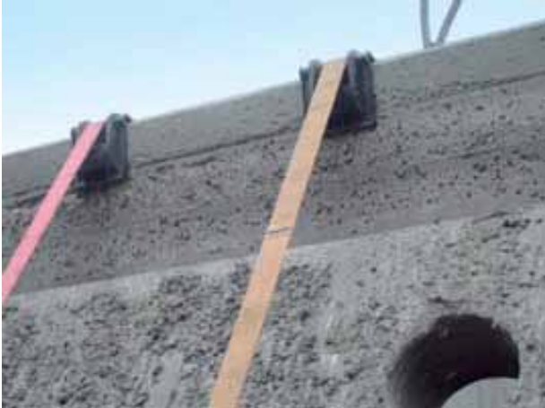
Bild 157: Einsatz von Kantengleitern
