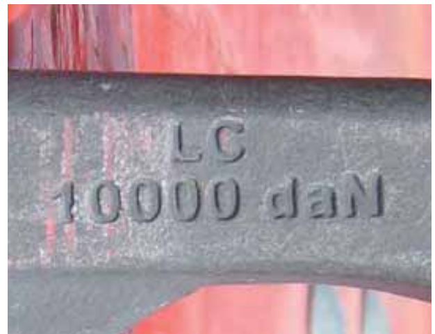
Bild 36 und 37: Neue Kennzeichnung von Zurrpunkten an Tiefladern
