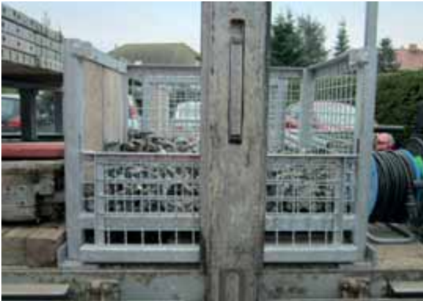
Bild 139 und 140: Sicherer Transport von Kleinmaterial in Gitterboxen
