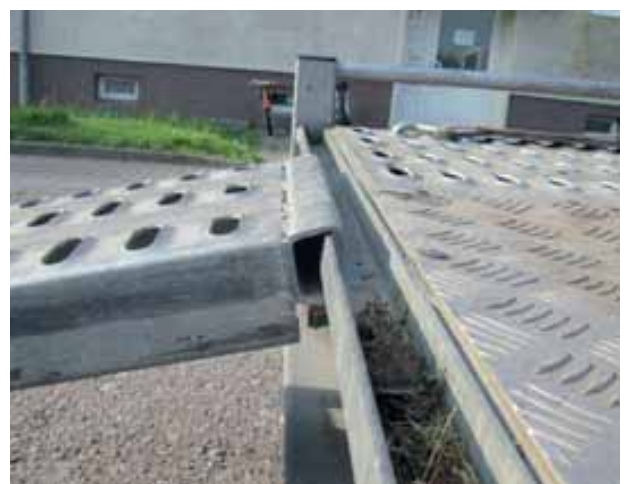
Bild 173: bestimmungsgemäße Verwendung, sicher arretiert
