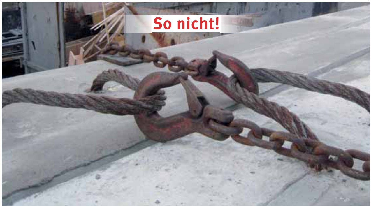
Bild 43: Drahtseilösen zum Heben von Betonfertigteilen als nicht zugelassene Zurrpunkte genutzt
