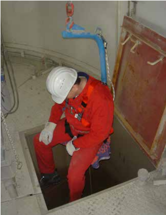
Abb. 71 Siloeinfahrereinrichtung und PSA gegen Absturz
