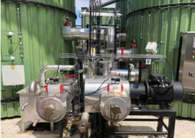
Abb. 17 Stationäre Pumpe zum Entladen von Bitumen
