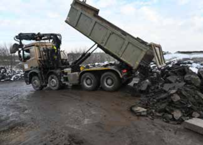
Abb. 11 Kippstelle auf der Halde (5 m vor der Kante)
