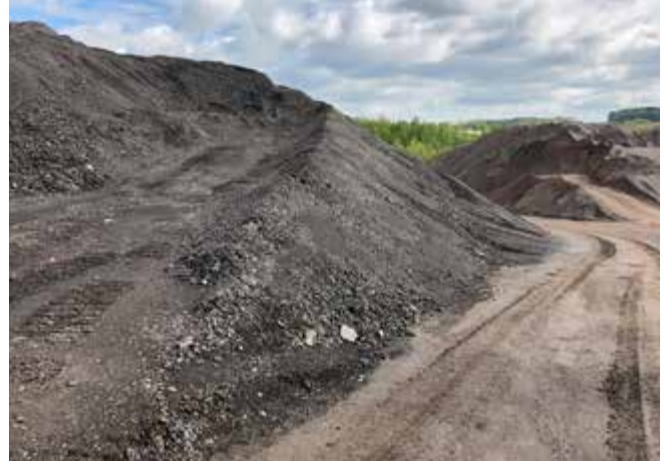
Abb. 10 eingefügte Zwischenebene auf Ausbausphalthalde
