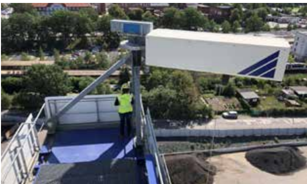
Abb. 78 Siebanlage mit festmontiertem und schwenkbarem Kran
