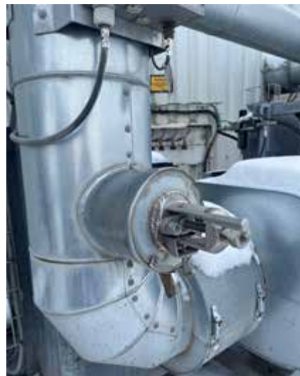
Abb. 81 Probennahme von Bitumen
