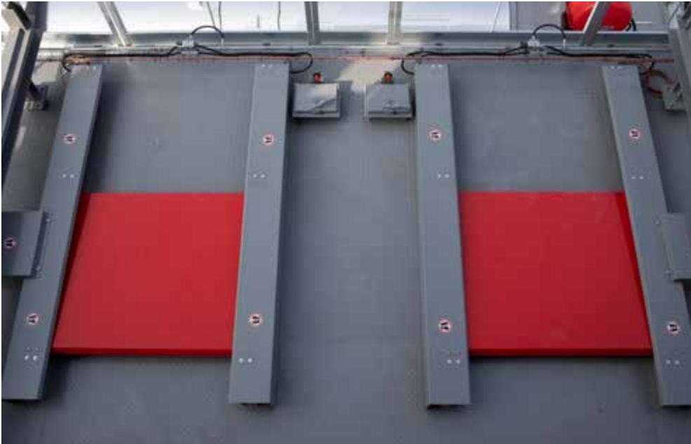
Abb. 68 Verfahrkübelebene mit Lukendeckeln
