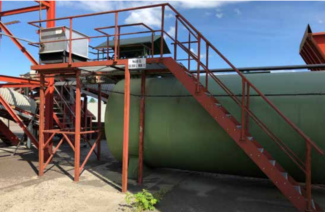
Abb. 20 sichere Zugänge und Standfläche zum Tankdom
