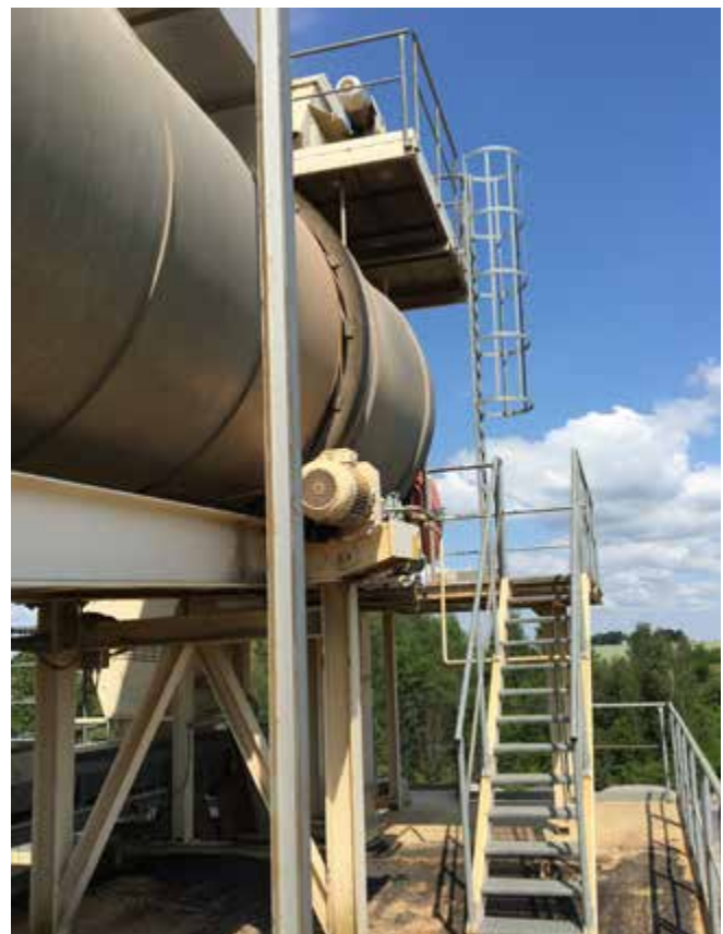
Abb. 58 Sichere Verkehrswege an hochgelegener Paralleltrommel
