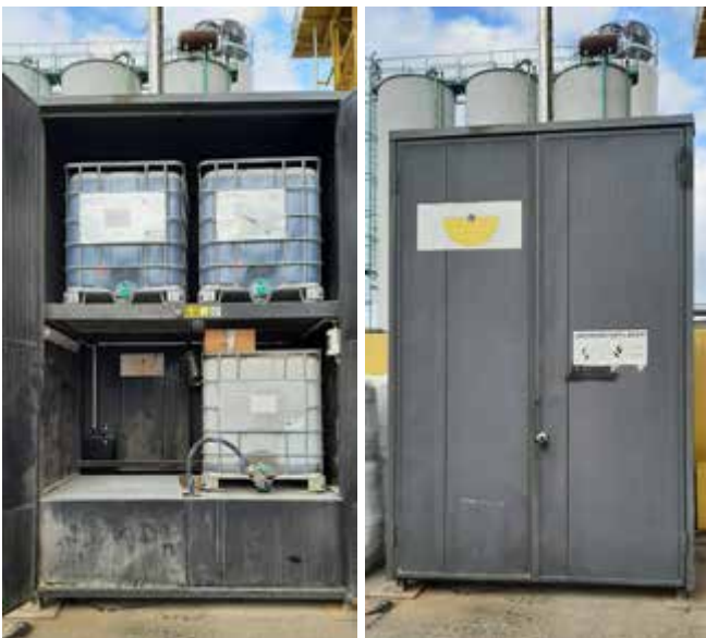
Abb. 18 Verschießbarer Schrank mit Auffangwanne für die Lagerung von Additiven in IBC-Behältern
