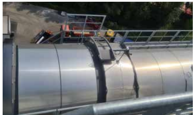
Abb. 76 Zugang zu Wartungsplatz, erhöhtes Gelände
