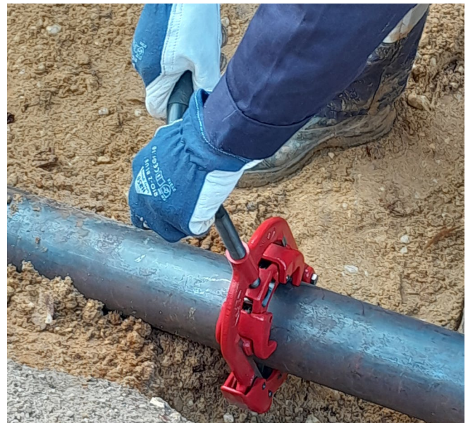
Abb. 44 Rohrschneider handbetätigt
